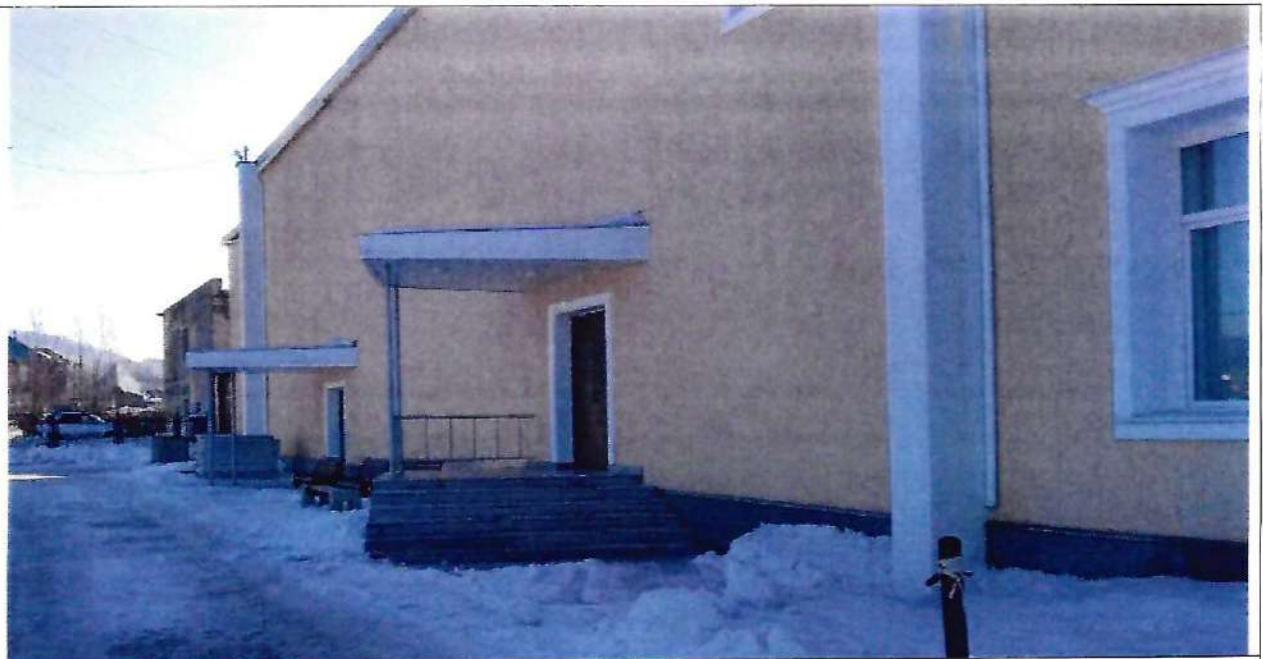
Фото № 17. Северный торец здания МБУ ГДК «Родина». Эвакуационные выходы.
